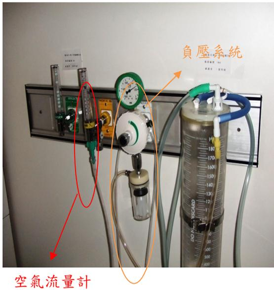
圖 3.2 流量計與負壓系統
