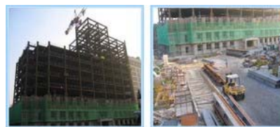
綜合教學大樓施工進度
