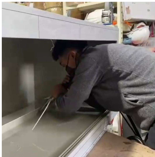
圖 7 熱風塑銲焊接作業
